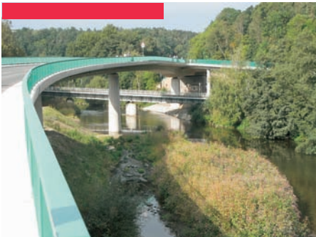
11 | Ortsumgehung Elsterberg Anbindung fertig gestellt. Foto: IHK
